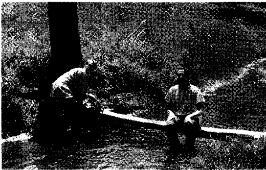
(ユタ州ローガン近郊の歩道橋を建築中のマーク)
